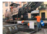
Al lavoro per la fresatura: asfalto addio in corso Garibaldi (A pagina 7)
